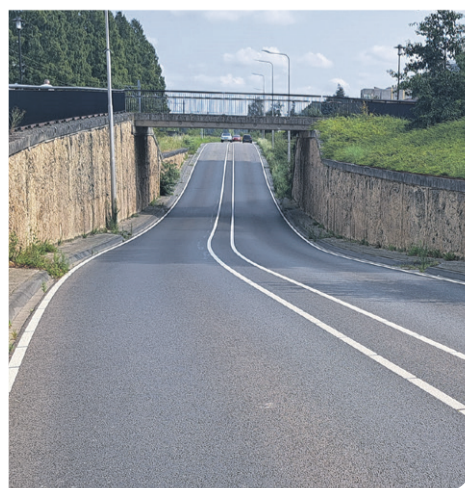
De wanden van de onderdoorgang Westelijke Randweg Lutterade krijgen
